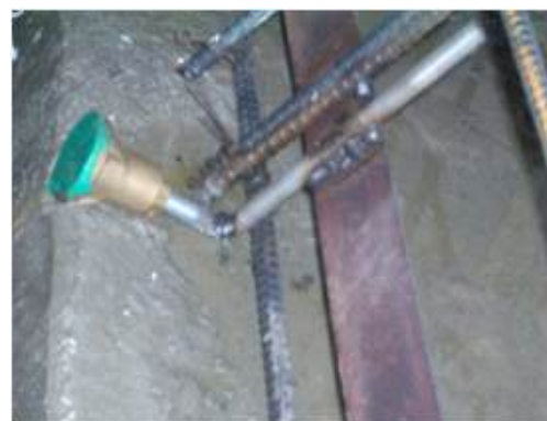
그림 18. 터널내 철근과 평철 및 접지 단자 설치
