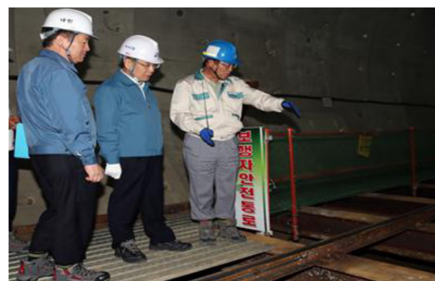
〈쉴드TBM 현장 점검〉
