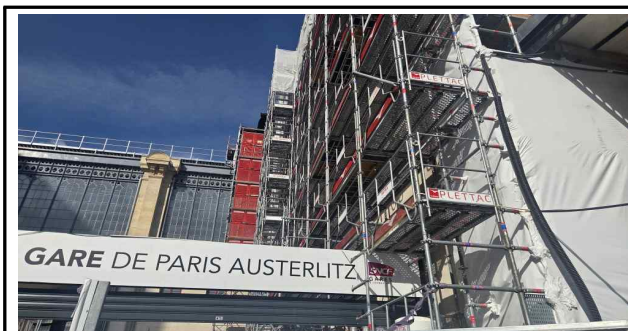
Gare d'Austerlitz 역사 개량 현장
