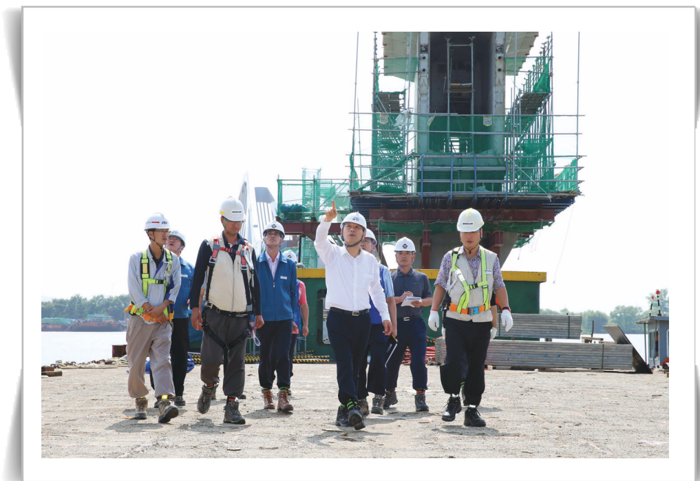
김광재 이사장은 8월 30일 포승~평택 철도, 호남고속철도 등 충청본부 건설현장을 방문하여 운영을 고려한 건설계획 및 과잉시설 없는 경제세계를 당부했다.
