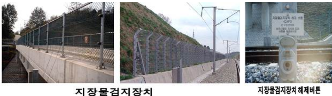
그림 2. 지장물 검지장치 설치
