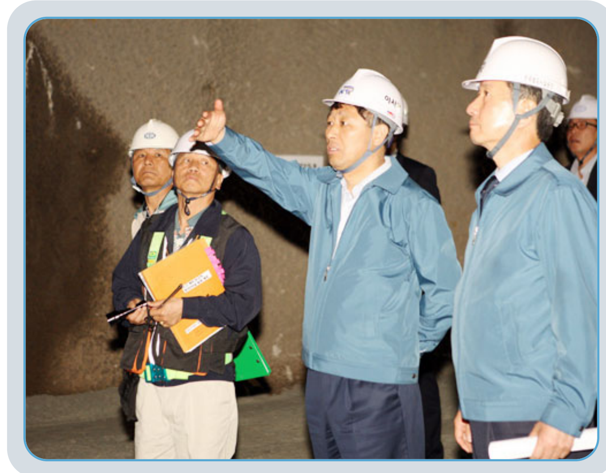
김광재 이사장은 지난 4일 호남고속철도 성덕제2터널, 모암터널, 규촌교 등 호남본부 건설현장을 방문하여 철도건설 현장의 재해발생률을 2020년도까지 0.05%까지 낮출 것을 당부하고, 고품질의 철도건설을 지시하였다.
