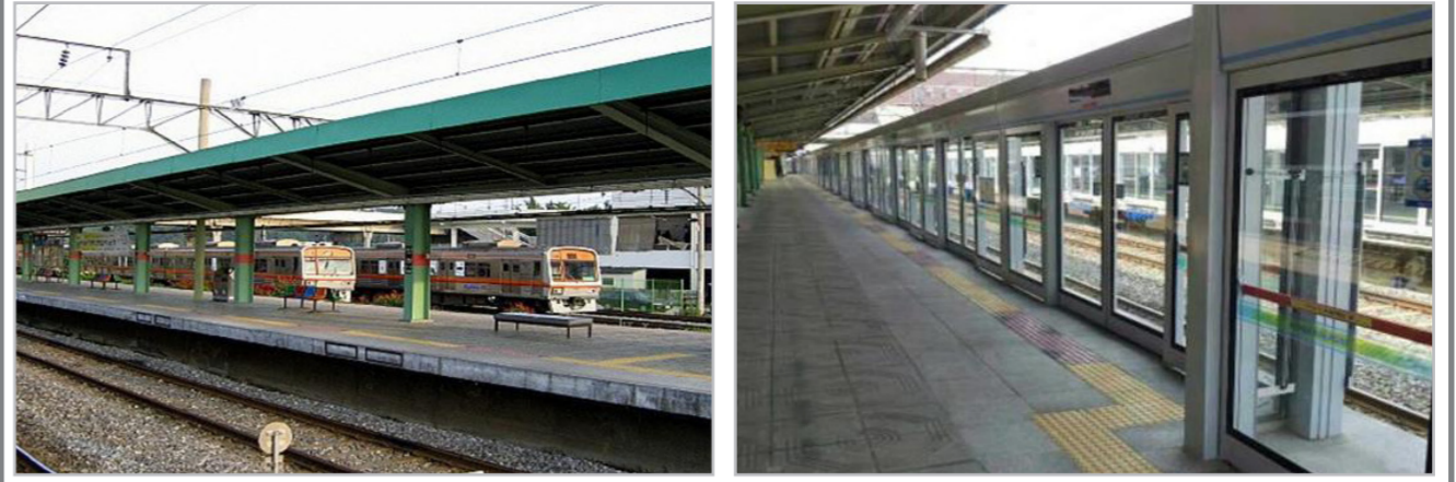
[참고4] 승강장 안전문 설치 전·후 사진
