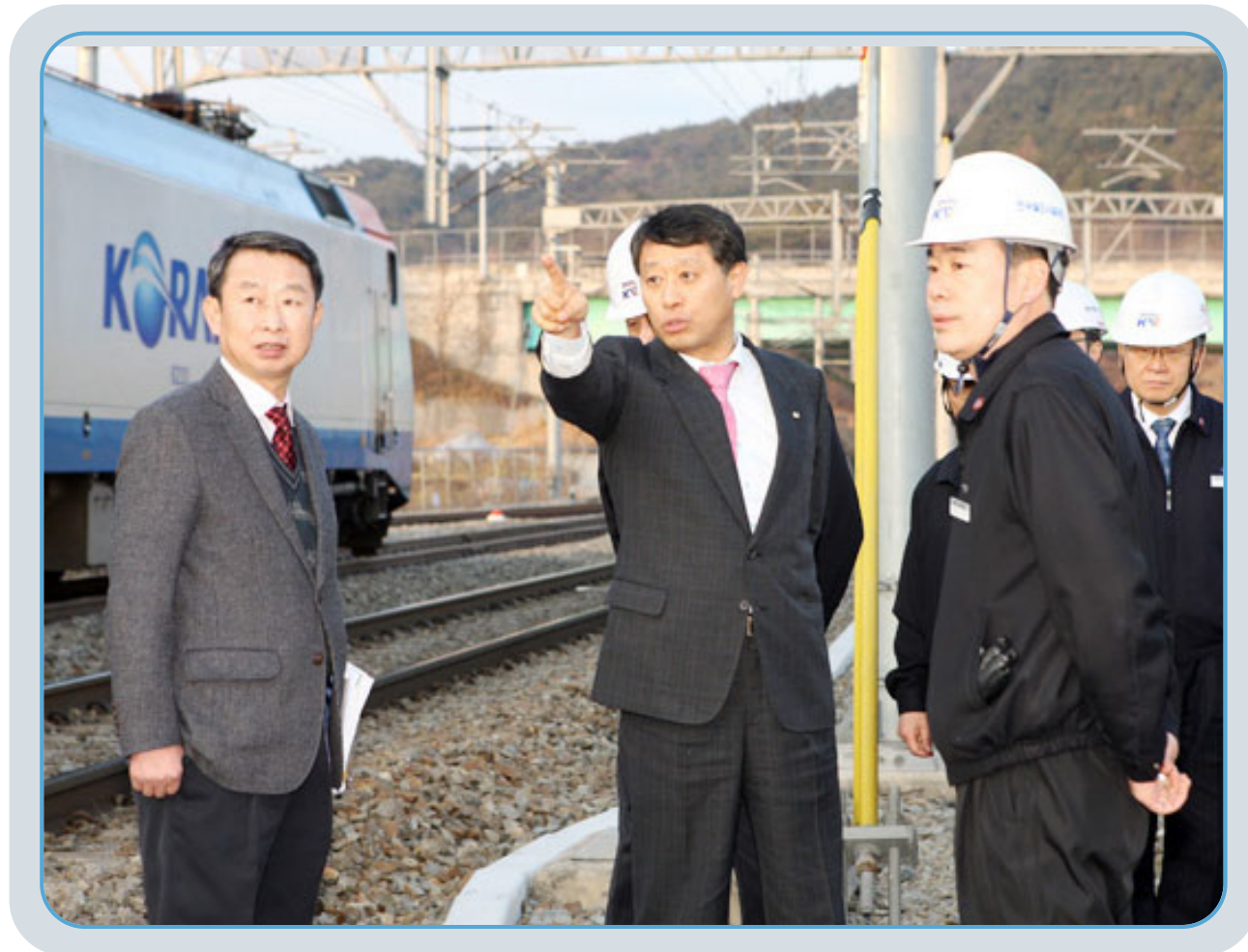
김광재 이사장은 지난 20일 남원역 구내 전라선 고속화 현장 및 남원역 신호계전기실 등 호남 본부 건설현장을 방문, "건설계획과 설계·시공 등 전과정에서 직원 개개인의 경영마인드를 도입하여 국민세금을 아끼는 방안을 수립하라."고 주문하였다.
