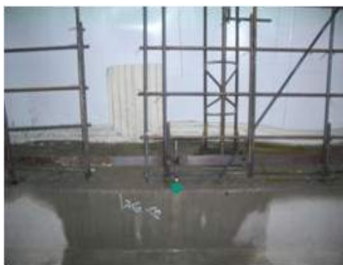
그림 12. 터널내 철근과 평철 및 접지 단자 설치
