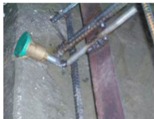
그림 12. 터널내 철근과 평철 및 접지 단자 설치
