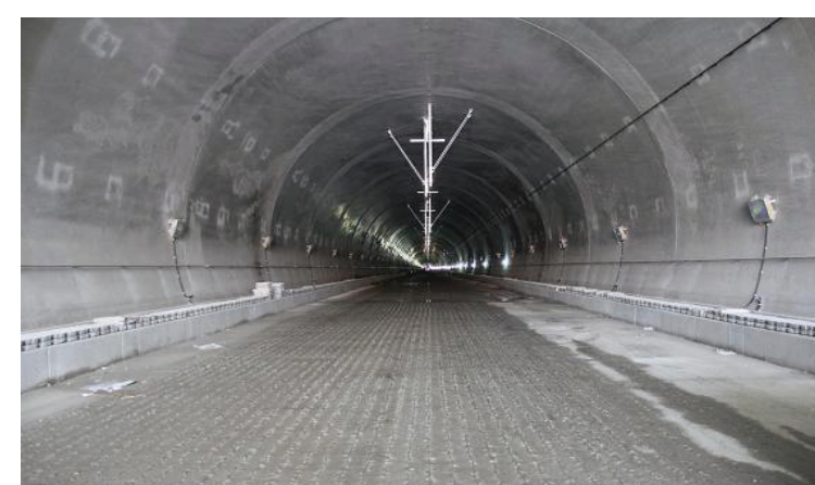
갈산터널 내부 시공완료 전경
