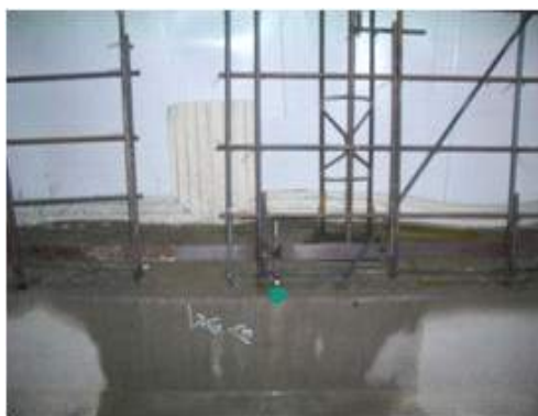
그림 18. 터널내 철근과 평철 및 접지 단자 설치
