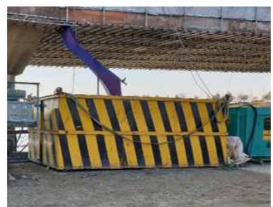
③ 집수조 설치
