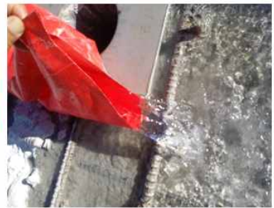
⑥ 슬러지 재활용처리 후 작업용수
