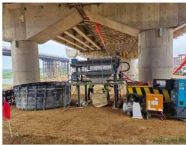
④ 슬러지 재활용 처리시설 설치
