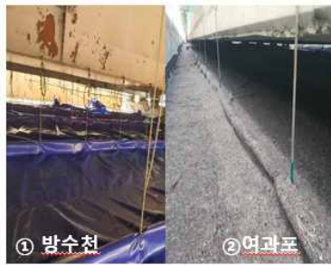
② 방수천 설치
