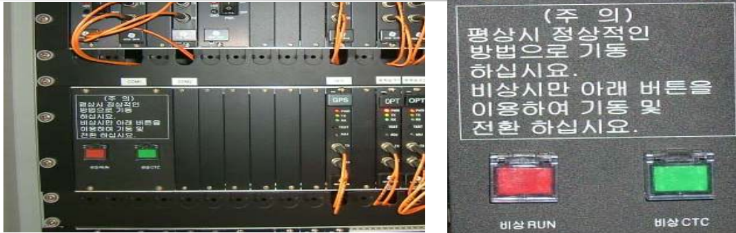
그림 145. 비상스위치 설치 위치
