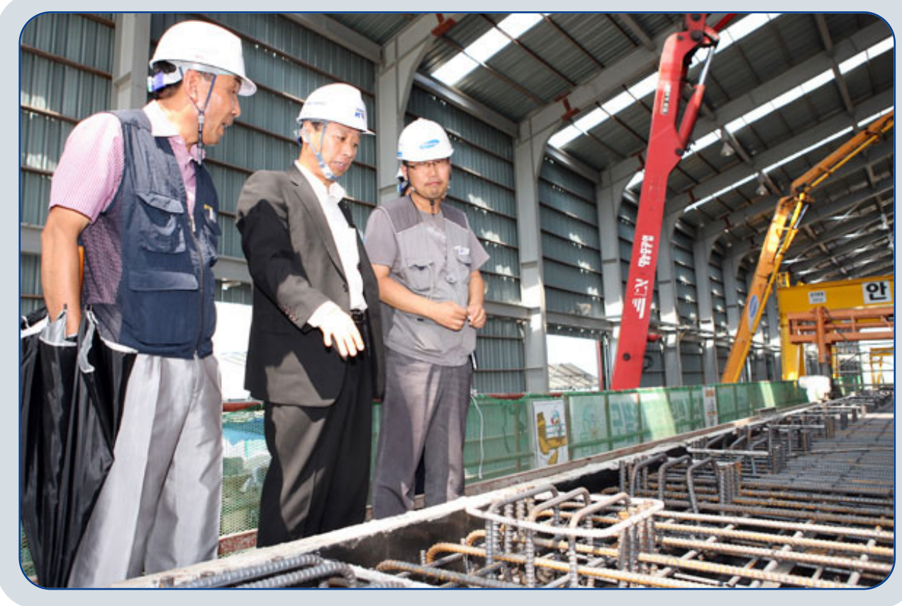
김광재 이사장은 지난 16일 호남고속철도 및 전라선 등 호남본부관내 건설현장을 방문하여 각종 현안사항을 둘러보고, 고품질의 철도건설이 이루어질 수 있도록 현장관계자들을 격려했다.
