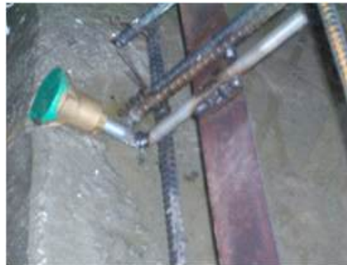
그림 18. 터널내 철근과 평철 및 접지 단자 설치
