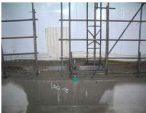
그림 18. 터널내 철근과 평철 및 접지 단자 설치
