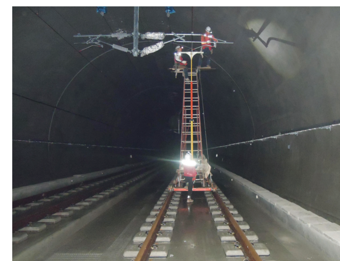
사다리차 전차선 가선 시공
