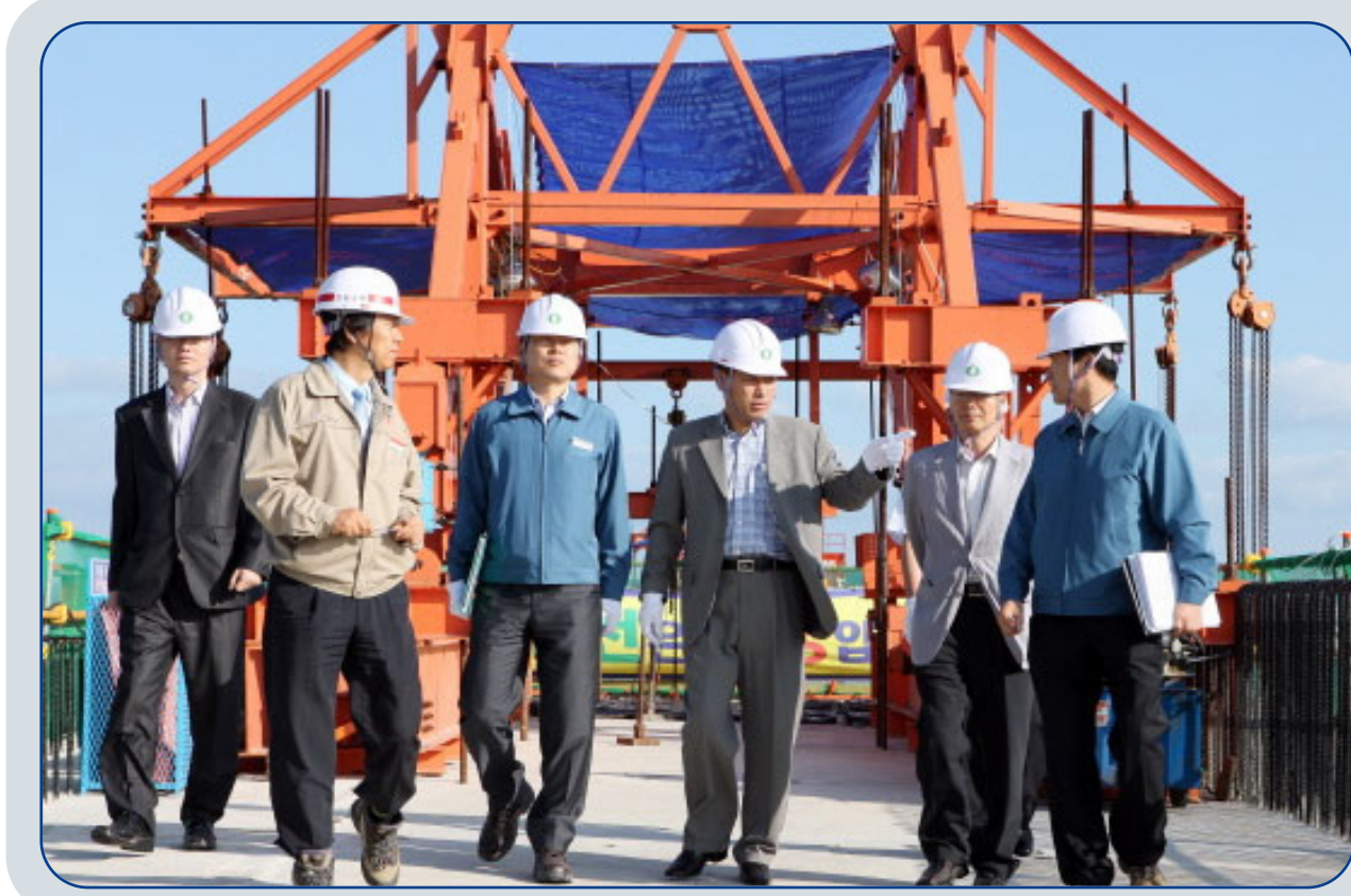
김광재 이사는 지난 3일 충청본부 호남고속철도 건설현장을 방문, 철저한 시공관리를 당부하고 현장관계자들을 격려했다.
