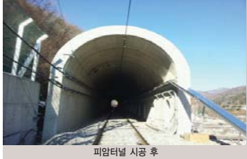
피암터널 시공 후
