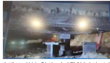
④ 슬래브 하부 임시 지지장치(나사 스펀들)
