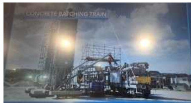
⑨ 현장 물류: 콘크리트 배합 열차와 자체 공급 설비
