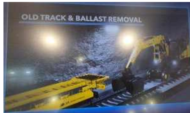
① 기존 궤광·자갈 철거: 굴착기로 궤광을 걷어 철거 열차에 적재
